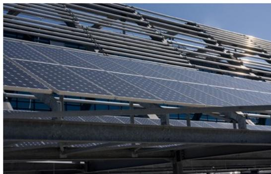
La Sede Unica, che si richiama esplicitamente ad un'architettura di tipo internazionale, è caratterizzata da elementi che si indirizzano verso una maggiore compatibilità ambientale: il soffitto radiante dove circola aria a bassa velocità per mantenere la temperatura omogenea senza caloriferi o impianti di riscaldamento, i pannelli fotovoltaici installati sulla copertura ad origami (figura 13), che serviranno ad alimentare il parcheggio multipiano.
